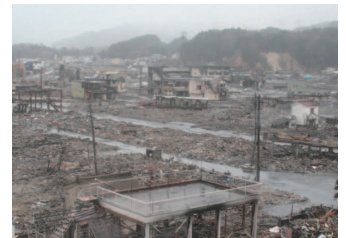
津波による災害
