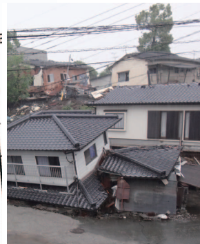
地震による倒壊 (熊本地震2016年)
